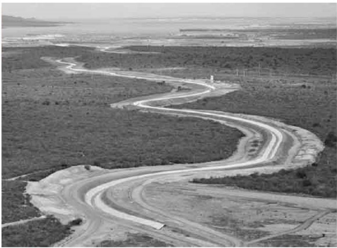
As empresas reafirmaram o compromisso de concluir os trabalhos até o final do ano.
