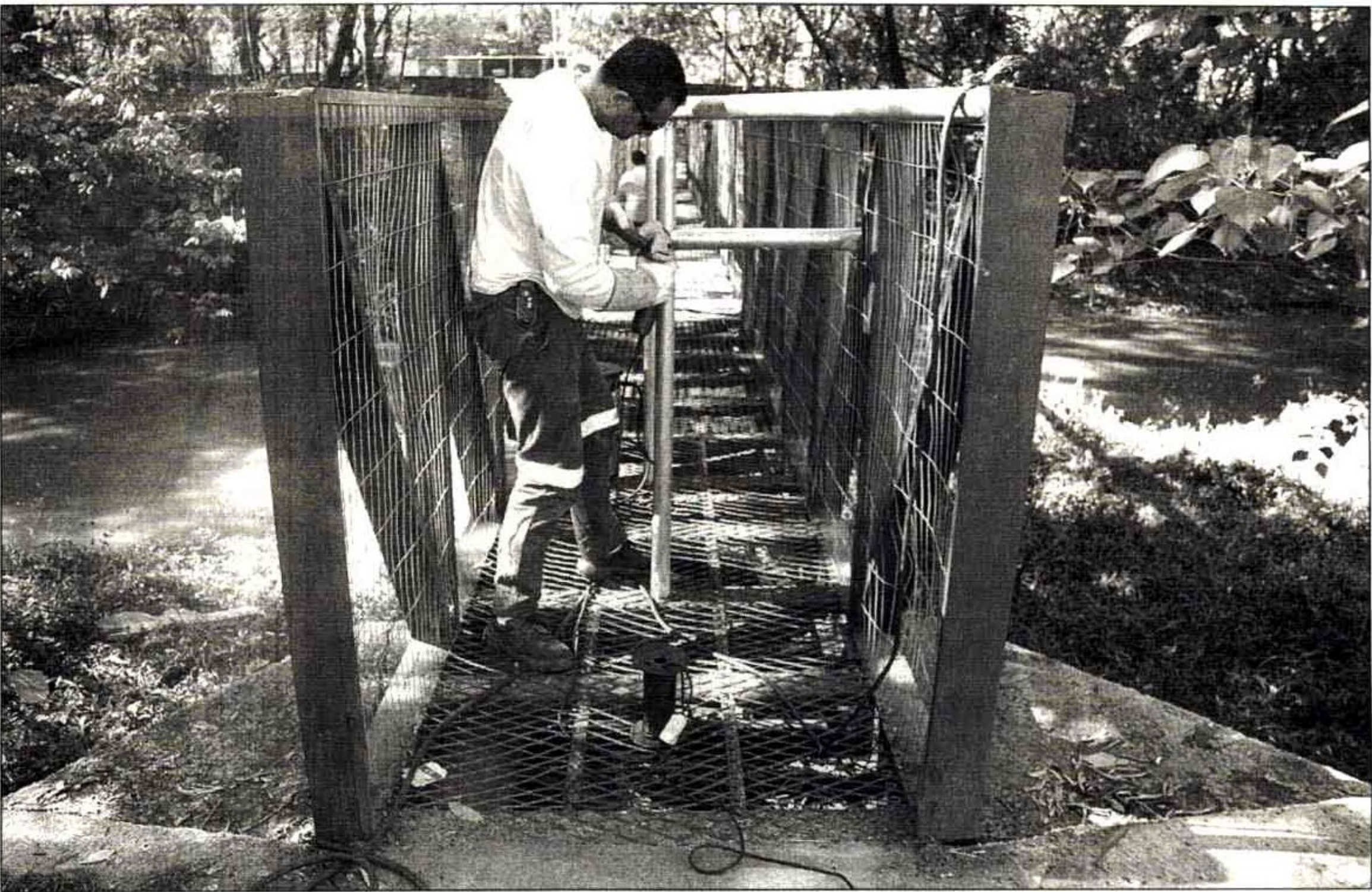
A passarela metálica sobre o Ribeirão da Penha, que liga a avenida dos Italianos ao Conjunto Residencial São Judas Tadeu, no bairro Cubatão, recebeu uma atenção especial na tarde de ontem. Funcionários do Saae (Serviço Autônomo de Água e Esgotos) soldaram barras de ferro que impossibilitam a passagem de motos pela estrutura, liberando o acesso somente a pedestres. O objetivo é preservar a estrutura da ponte, assim como a tubulação que passa ao lado.
